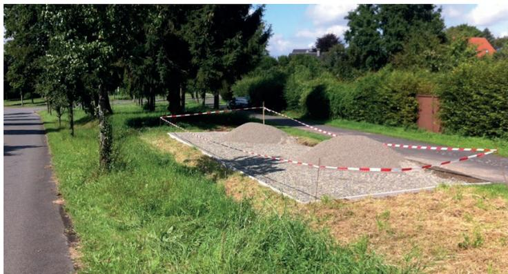
wurde bereits der Mutterboden entfernt, Boden ausgehoben, die Schottertragschicht eingebracht und Rasenkantensteine gesetzt. Der Splitt für die obere Schicht war auch schon angeliefert worden.
